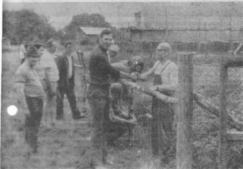
Mit vereinten Kräften errichtete man einen neuen Zaun — in ausreichender Entfernung vom Ufer. (Int.-Foto)
